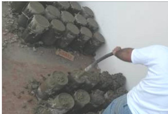
Figura 3.7 – Adensamento mecânico com uso de vibrador de imersão.
